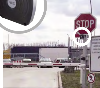
Die Weitbereichsleser wurden an Verkehrsschildern angebracht.
